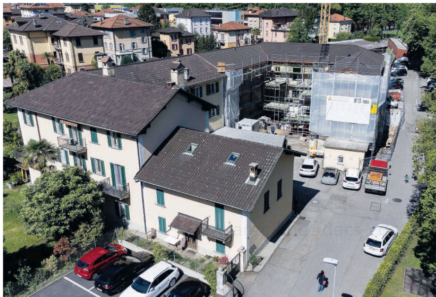
Una panoramica della struttura che sta sorgendo in via Guisan
